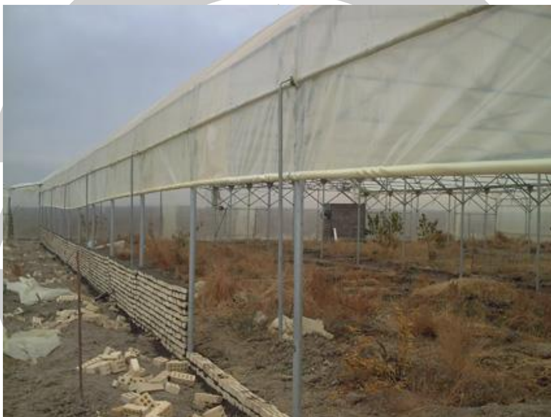
شکل ۱- مراحل ساخت گلخانه
