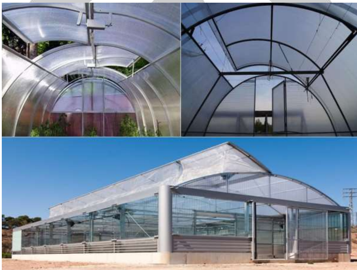
شکل ۱- پنجره‌های سقفی برای انجام تهویه طبیعی در گلخانه
