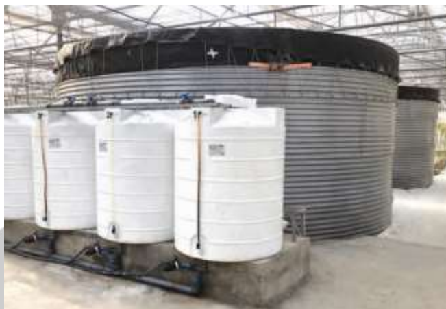
شکل ۲- مخزن نگهداری آب و کود در گلخانه
