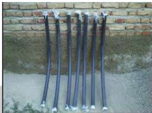
شکل ۱- پر کردن و مسدود کردن دهانه‌های لوله
