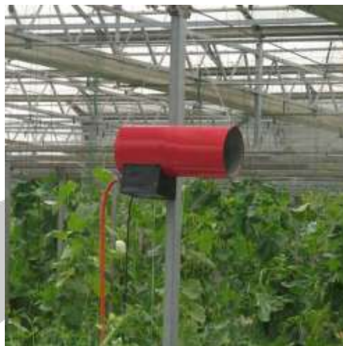
شکل ۱- دستگاه تولید کننده دی‌اکسید کربن در گلخانه
